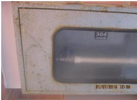
Foto No. 7 Gabinetes Oxidados
