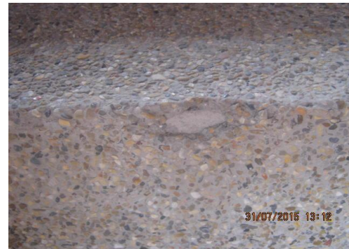
Foto No. 8 Acabados en escaleras defectuosos
