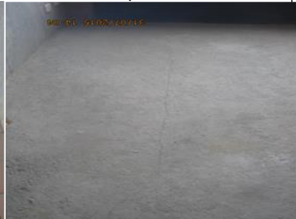
Foto No. 6 Placa de piso fisuradas
