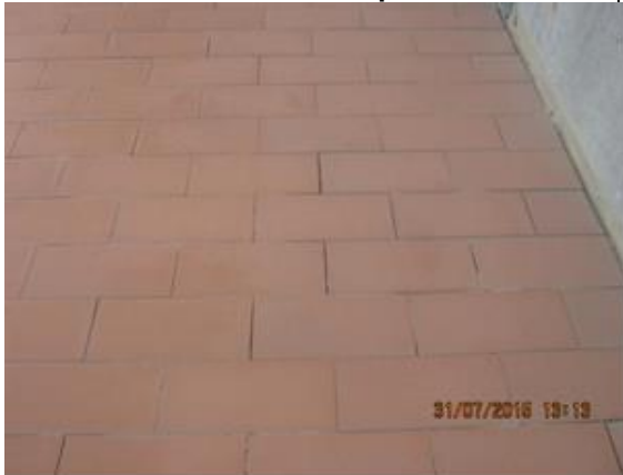
Foto No. 5 Pisos sin emboquillar
